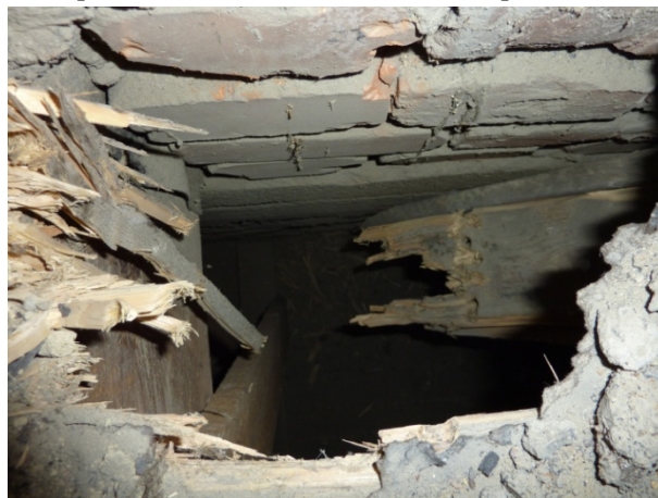
Obr. 8.24: Kopaná sonda v trámovém stropu – zámek Bílovec
