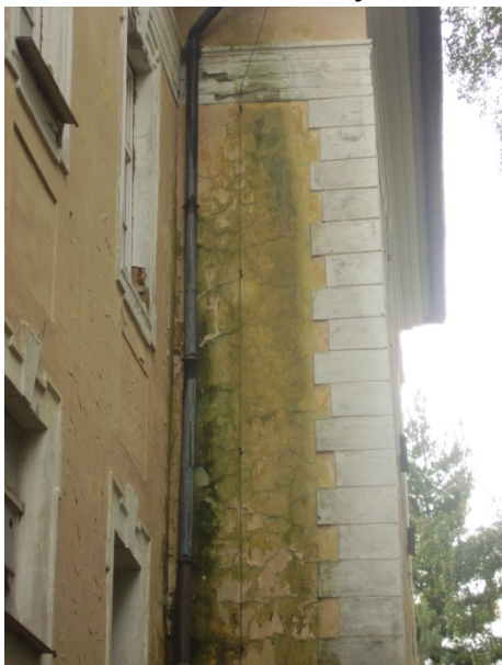
a) Biologické depozity kolem svislých svodů
