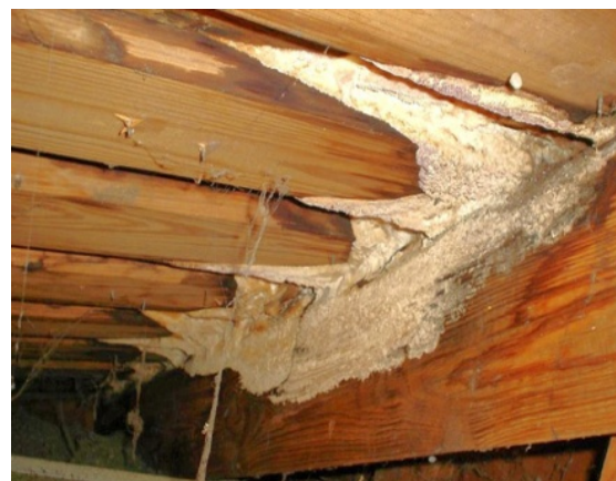
Obr. 8.22: Rozsáhlý atak dřevomorky domácí
