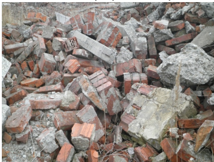
Obr. 8.10: Demoliční suť v areálu bývalých Hrušovských chemických závodů
