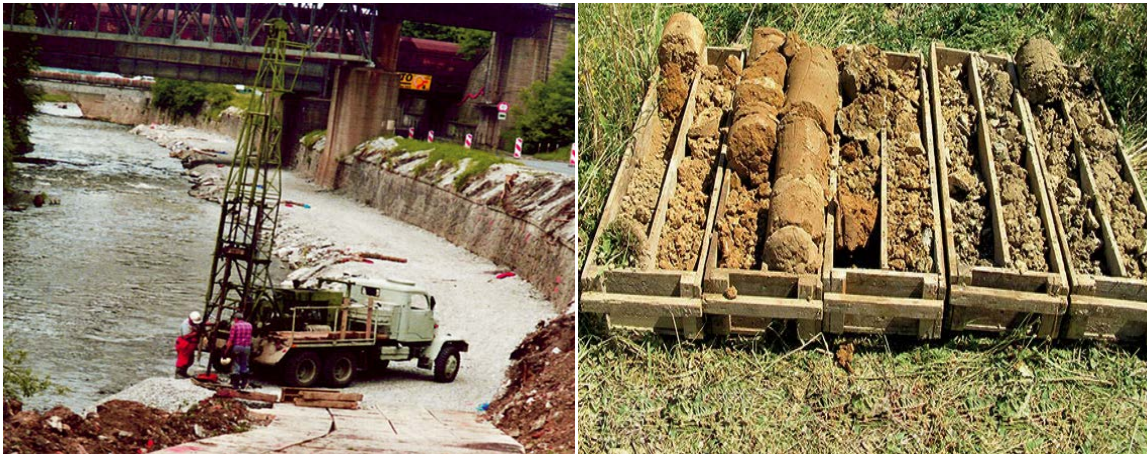
a) Vrtací souprava
