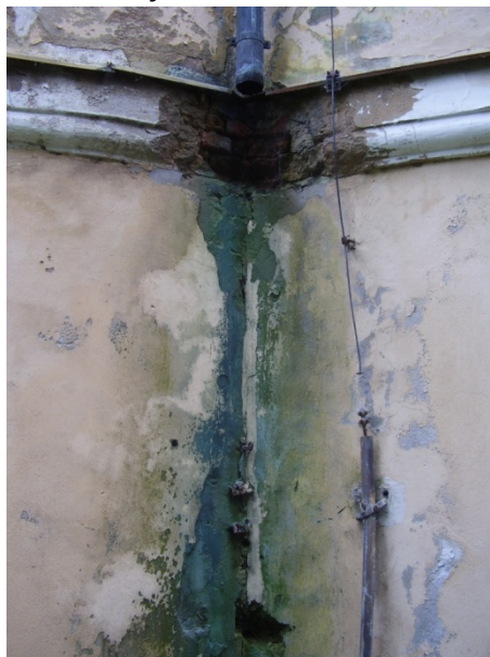
b) Degradace patrové římsy
